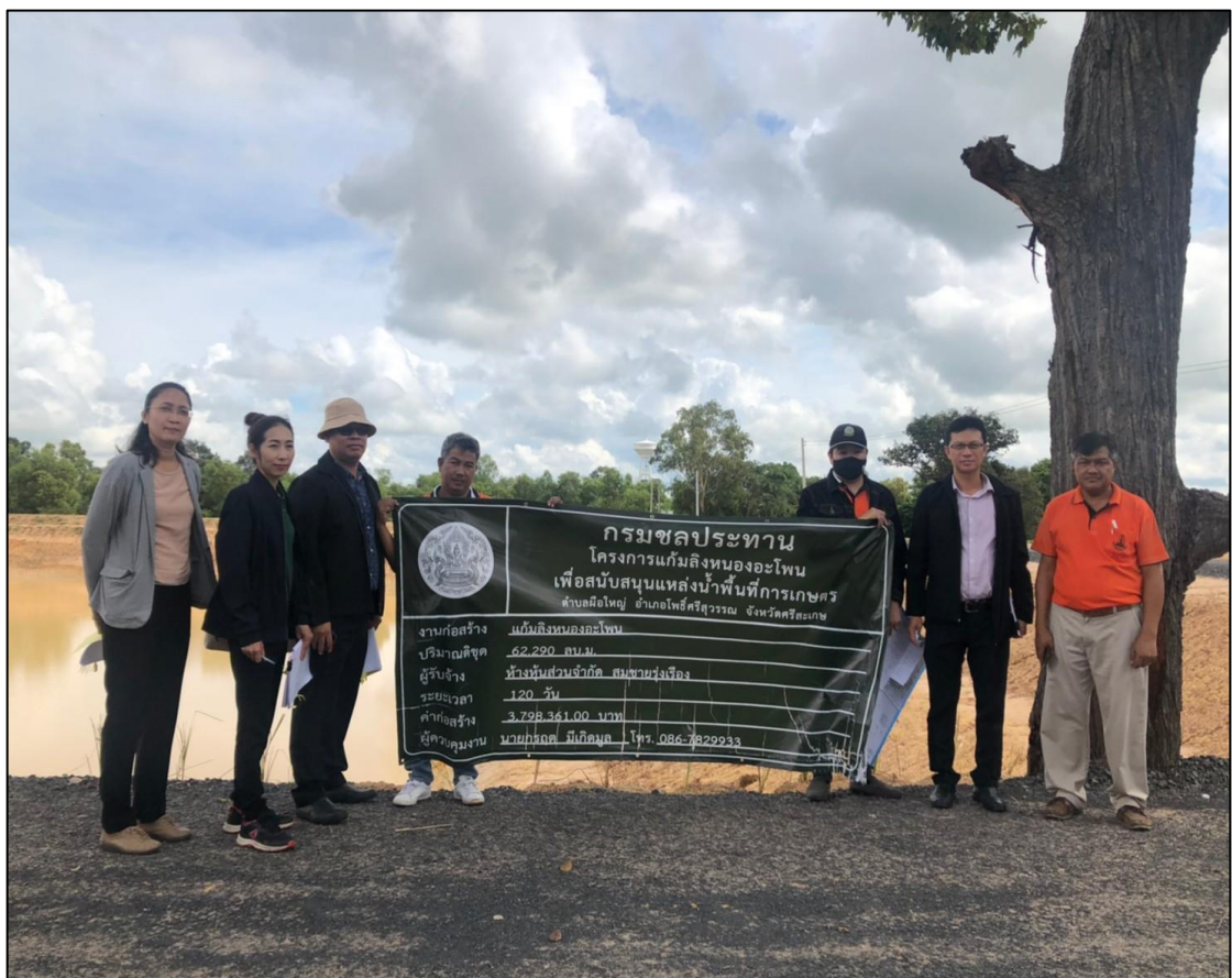
ภาพที่ ๔ บริเวณพื้นที่หลังดำเนินการขุดลอกแก้มลิงหนองอะโพนฯ
