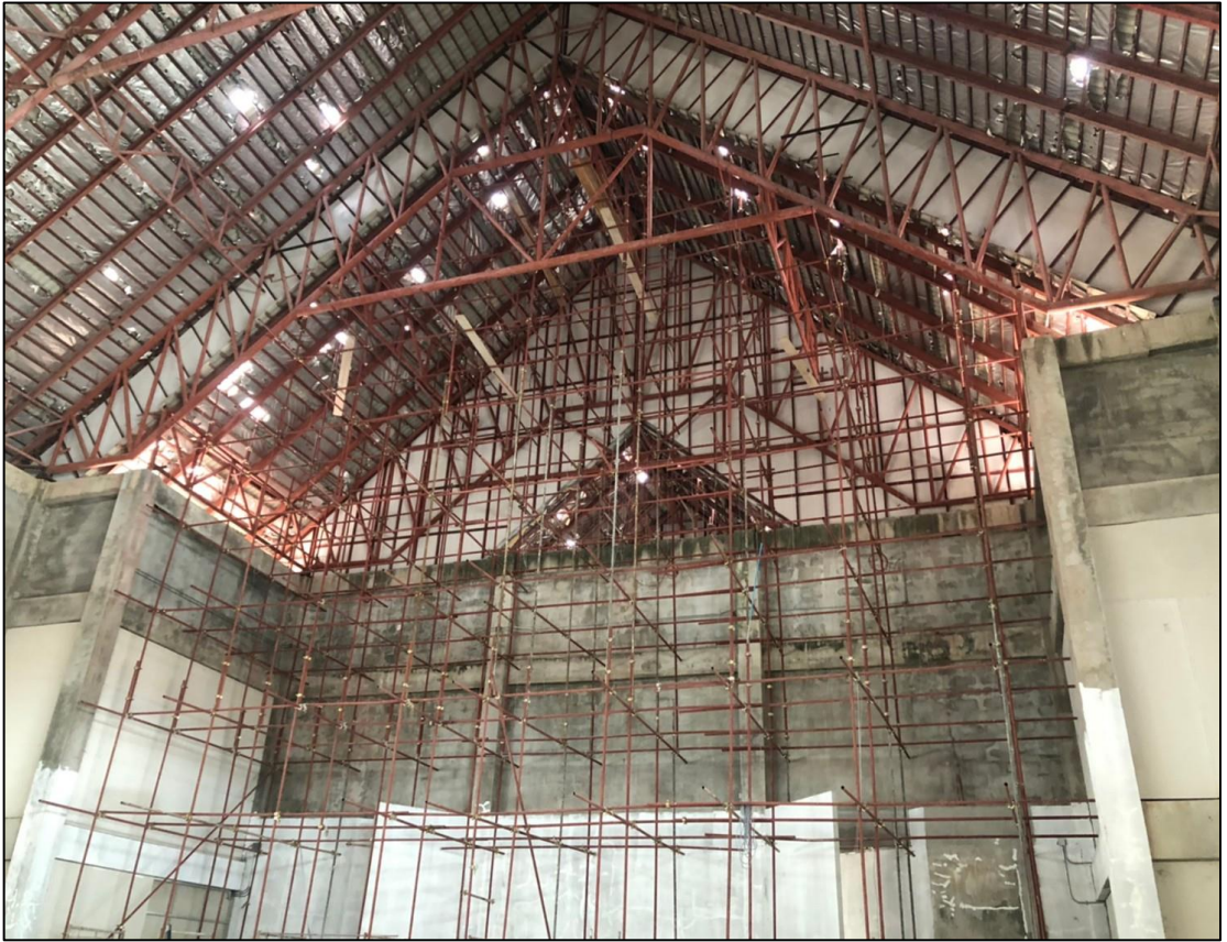
ภาพที่ ๓ บริเวณภายในอาคารอเนกประสงค์
