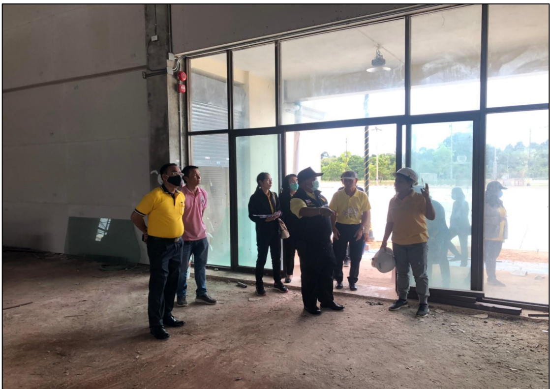
ภาพที่ ๒ บริเวณพื้นที่ดำเนินการก่อสร้างอาคารอเนกประสงค์
