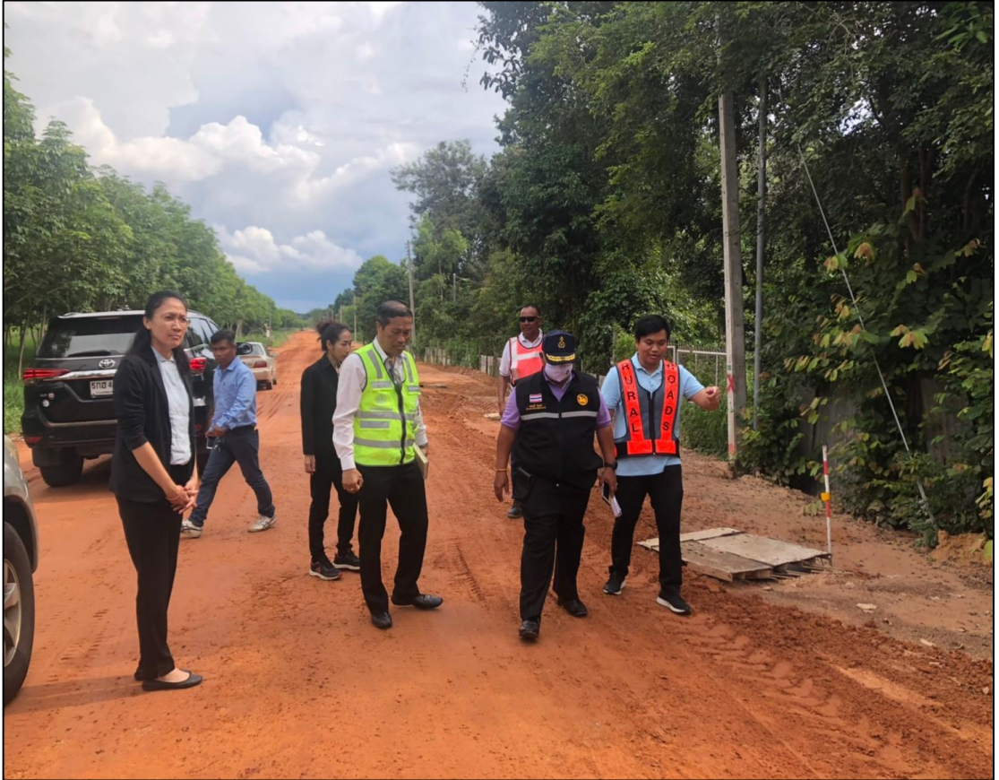
ภาพที่ ๕ บริเวณพื้นที่ดำเนินการ
