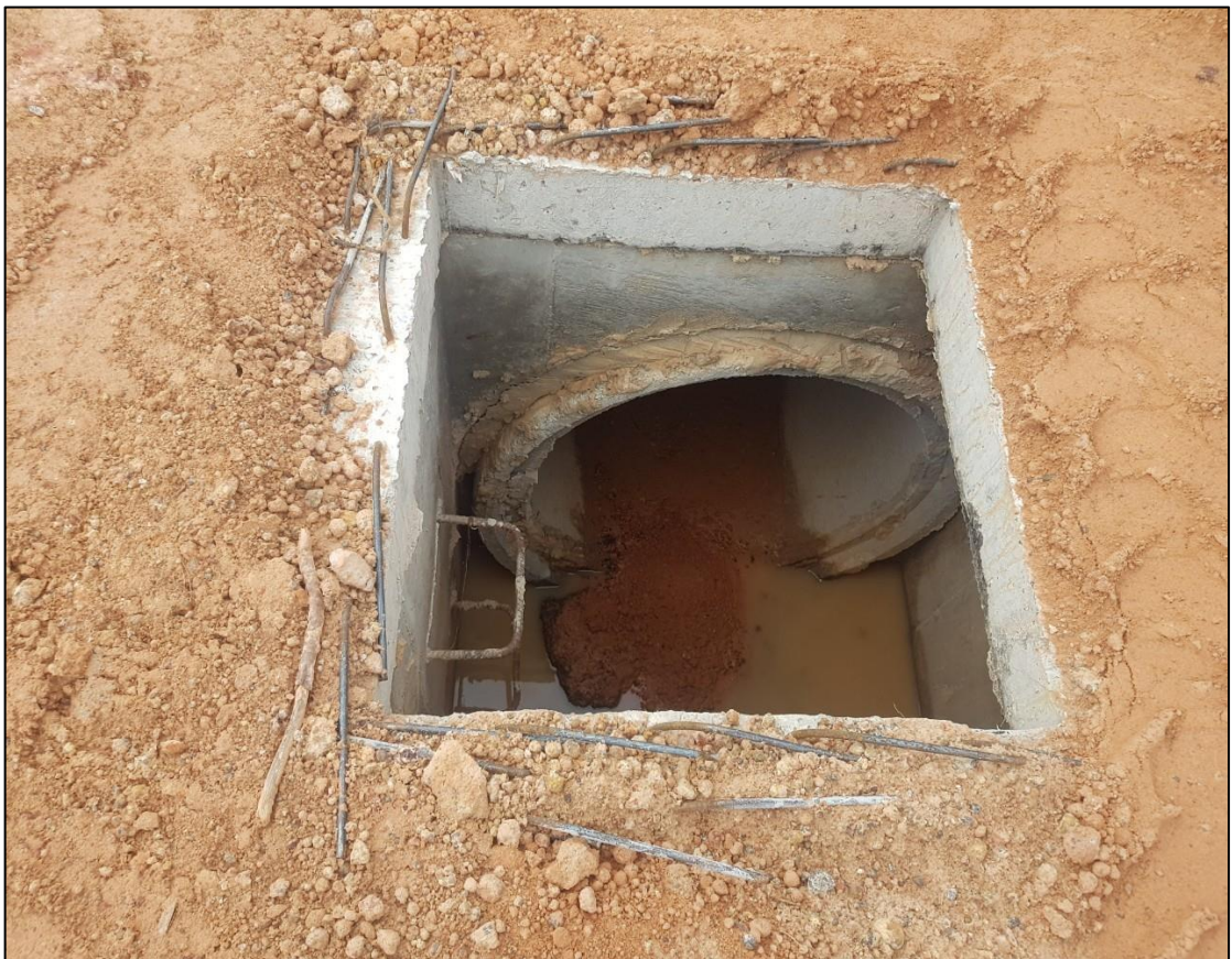
ภาพที่ ๖ บริเวณพื้นที่ดำเนินการ
