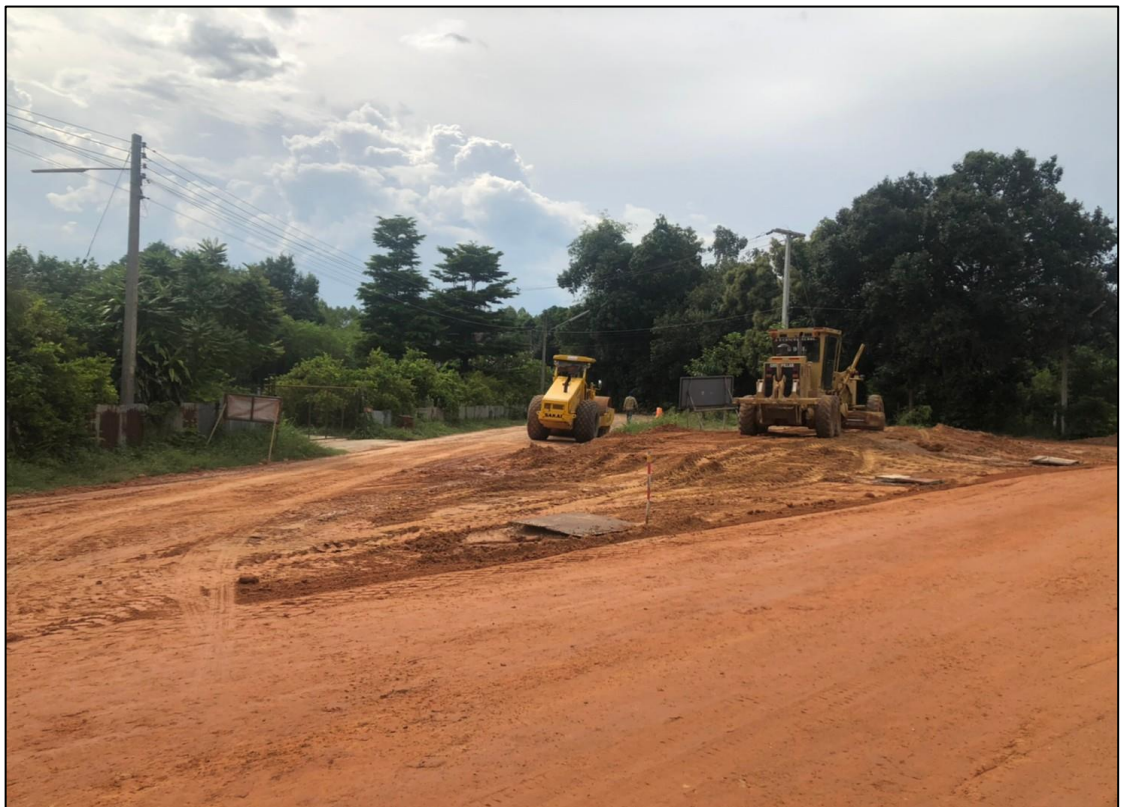
ภาพที่ ๒ บริเวณพื้นที่ดำเนินการ
