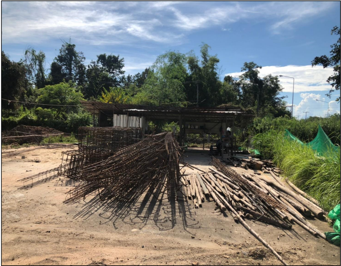
ภาพที่ ๓ บริเวณพื้นที่ดำเนินการก่อสร้างโรงผลิต ณ โรงพยาบาลเบญจลักษณ์
