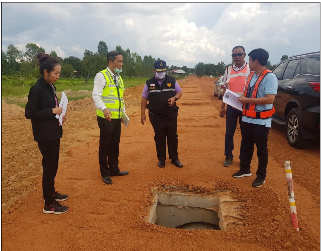
ภาพที่ ๔ บริเวณพื้นที่ดำเนินการ
