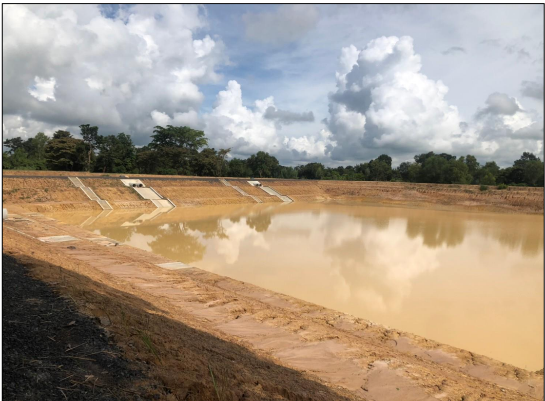
ภาพที่ ๒ บริเวณพื้นที่ดำเนินการขุดลอกแก้มลิงหนองอะโพนฯ
