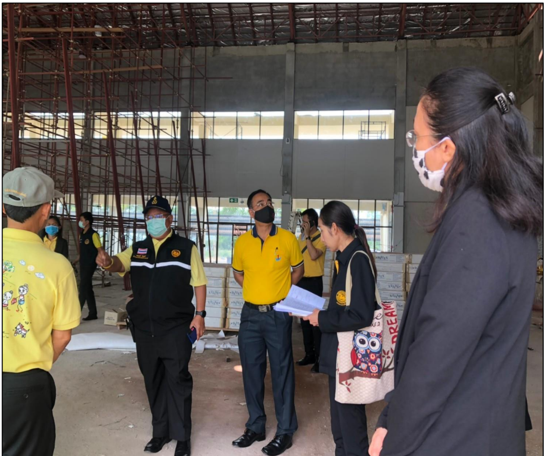
ภาพที่ ๔ บริเวณภายในอาคารอเนกประสงค์
