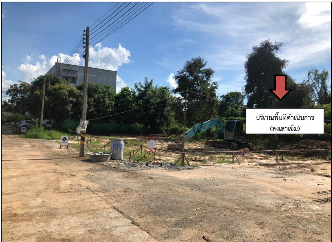
ภาพที่ ๒ บริเวณพื้นที่ดำเนินการก่อสร้างโรงผลิต ณ โรงพยาบาลเบญจลักษณ์
