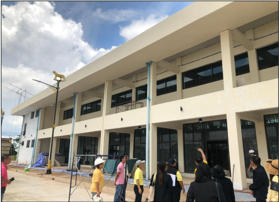
ภาพที่ ๑ บริเวณพื้นที่ดำเนินการก่อสร้างอาคารอเนกประสงค์
