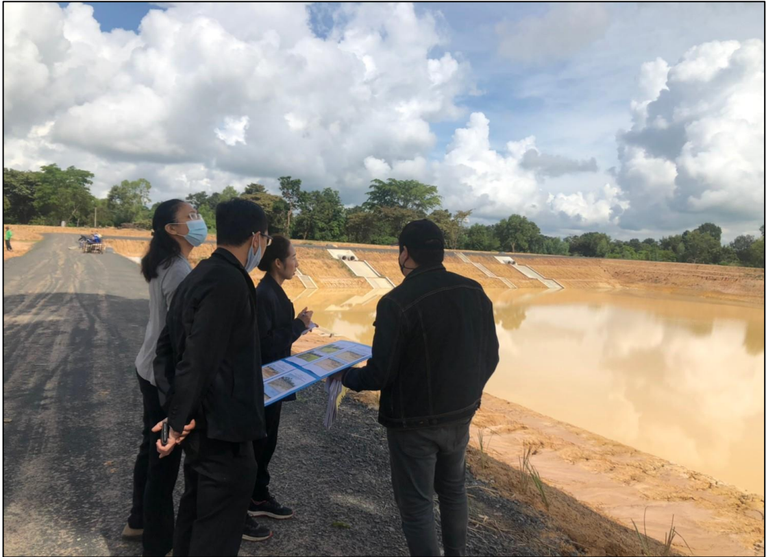
ภาพที่ ๑ บริเวณพื้นที่ดำเนินการขุดลอกแก้มลิงหนองอะโพนฯ
